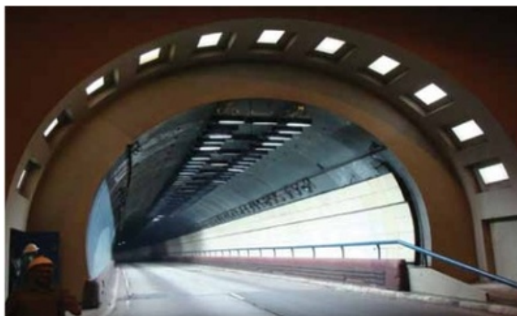
Figura 33- Túnel Nove de Julho na cidade de São Paulo. Fonte: Lâmpadas e Leds – Portal o Setor Elétrico, Ed. 46 – Novembro de 2009
