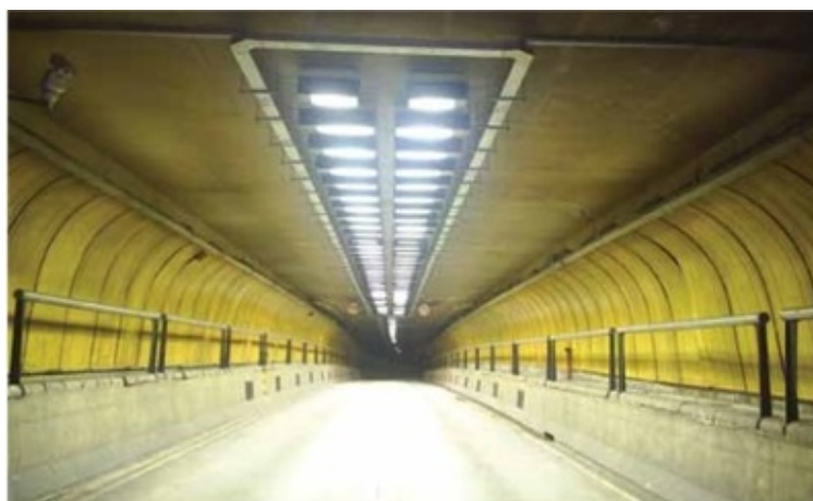
Figura 32-Túnel Jânio Quadros na cidade de São Paulo. Fonte: Lâmpadas e Leds – Portal o Setor Elétrico, Ed. 46 – Novembro de 2009
